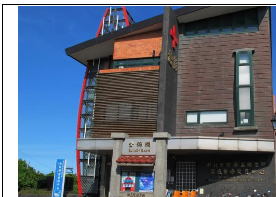
貢寮區衛生所
